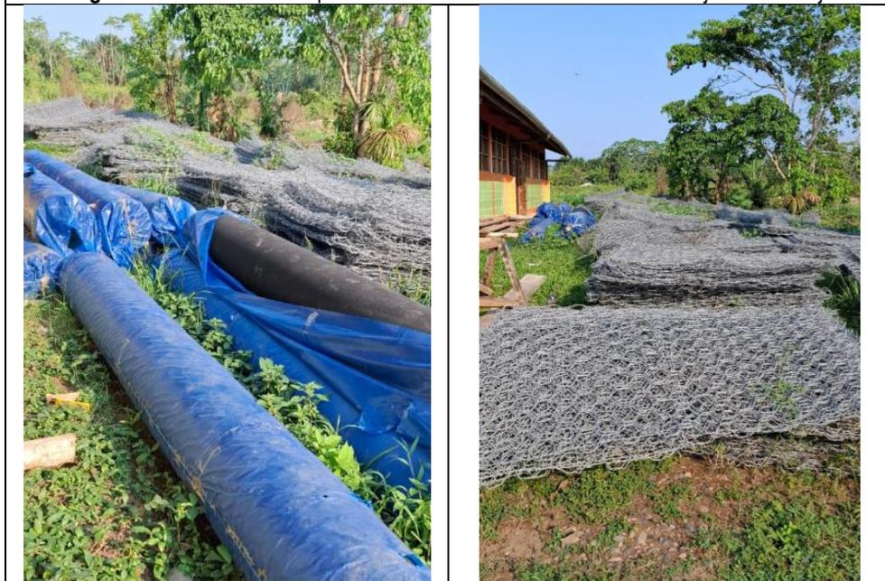
**Fotografía n.º 3:** Se observó rollos de geotextil a la intemperio.
