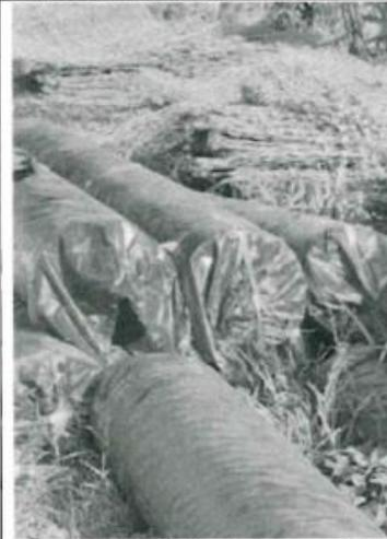
Fotografía n.º 04: Se observó rollos de geotextiles almacenados a la intemperie.
