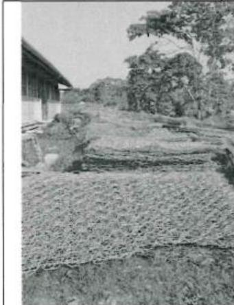
Fotografía n.º 05: Se observó malla para los gaviones almacenados a la intemperie.
