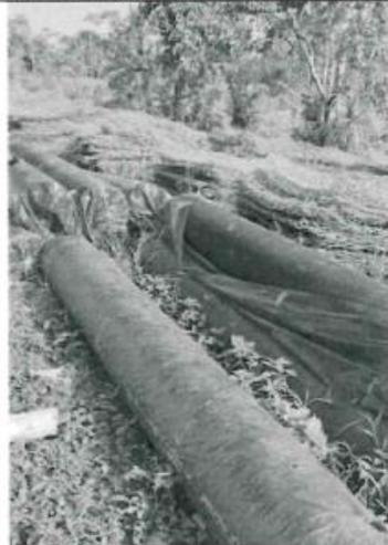
Fotografía n.º 03: Se observó rollos de geotextiles almacenados a la intemperie.
