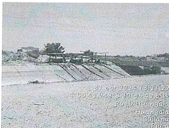
Motobombas no autorizadas listas para funcionar en Canal Daniel Escobar – Progresiva 26+300
