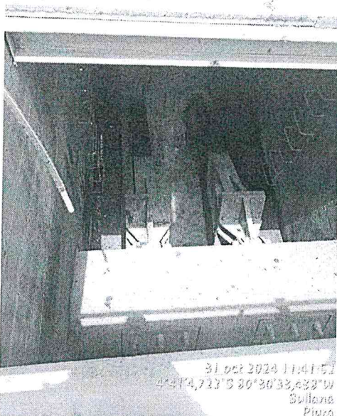
Salida de agua de Compuerta N°1 de Sección 4 Bocatoma – Canal de Derivación, debido a desgaste en sellos de compuerta
