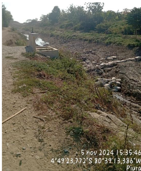
Imagen n.° 12 Punto de captación en el Km 27+510 del canal Miguel Checa
