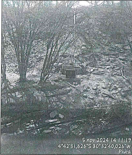
Presencia de Motobomba en canal Miguel Checa – progresiva 4+083
