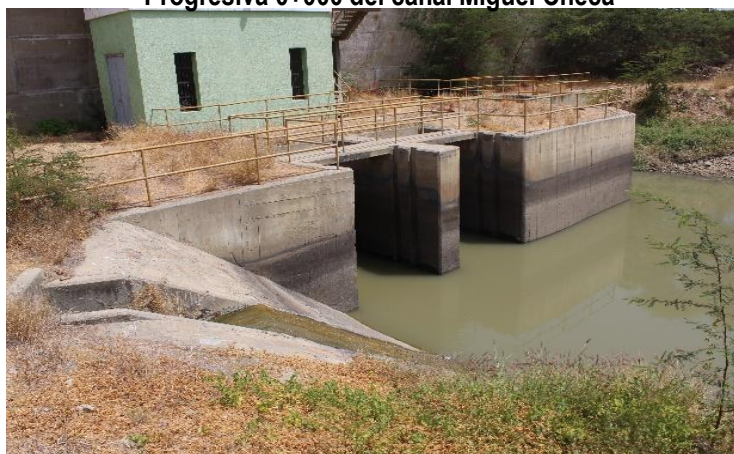
Imagen n.º 9 Progresiva 0+000 del canal Miguel Checa
