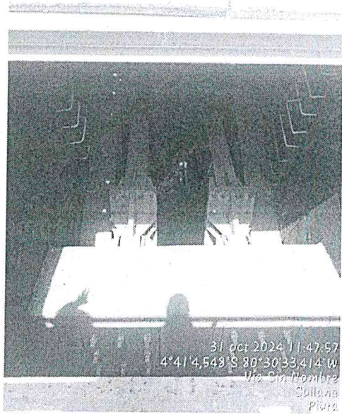
Salida de agua de Compuerta N°2 de Sección 4 Bocatoma – Canal de Derivación, debido a desgaste en sellos de compuerta
