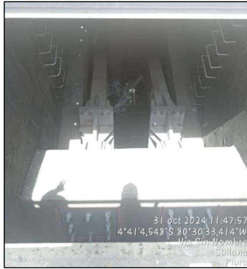
Imagen n.º 6 Salida de agua de Compuerta N°2 de Sección 4 Bocatoma – Canal de Derivación
