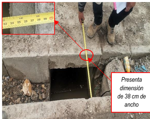
FOTOGRAFÍA N° 42 VISTA DONDE SE OBSERVA LA ENTRADA DE ALCANTARILLA 1+560 KM
