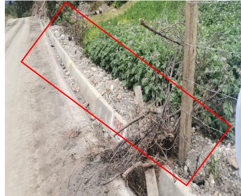
Fuente: Acta de inspección física de obra n.º 002-2024-MDSM/OCI-SCC-TRANSITABILIDAD
