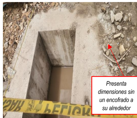
FOTOGRAFÍA N° 43 VISTA DONDE SE OBSERVA SALIDA DE LA ALCANTARILLA 1+560 KM
