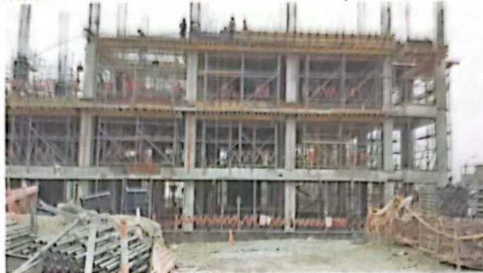
Imagen n.º 04 Vista lateral de la estructura aislada del sector "A" – ejecución de losa 3er nivel.
