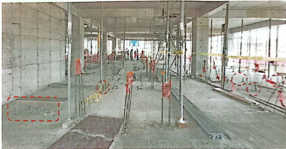
Imagen n.º 05 Pases en losa – vista primer nivel.
