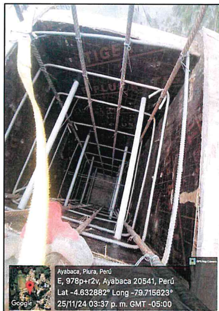
Fotografía n.º 2 Acero de refuerzo longitudinal de 5/8"
