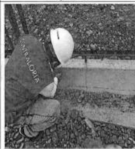
En las imágenes se puede apreciar el sobrecimiento del cerco perimétrico sin la aplicación de mortero 1:5; asimismo, el cerco perimétrico que comprende la PTAR no se encuentra pintada
