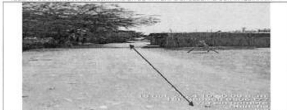
En la imagen se aprecia el último tramo de la Calle E Mz. A del Centro Poblado Chamorro Bajo Sector 1, en el que NO FUERON CONCLUIDAS las Partidas 06.02.01 y 06.02.21 de Excavación de zanja T.N. hasta H-1.50 m para tubería de 200 mm y Eliminación de material excedente con maquinaria respectivamente, correspondientes a la red de alcantarillado.
